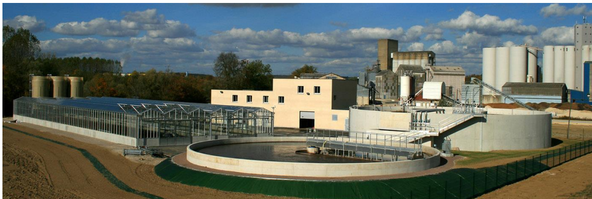
Figure 1 : Photo de la STEP de Nogent-sur-Seine (sogea-est.fr)
